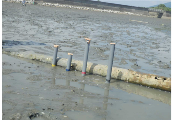
湧水調査（設置状況）
