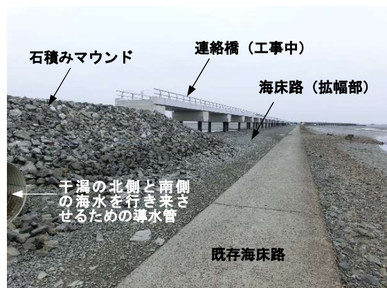
図 2.3.14 曾根漁港連絡橋工事による橋脚 と仮設道路 (2017年6月撮影)
